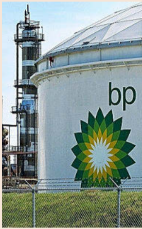
Refinería de BP en Texas, Estados Unidos.
